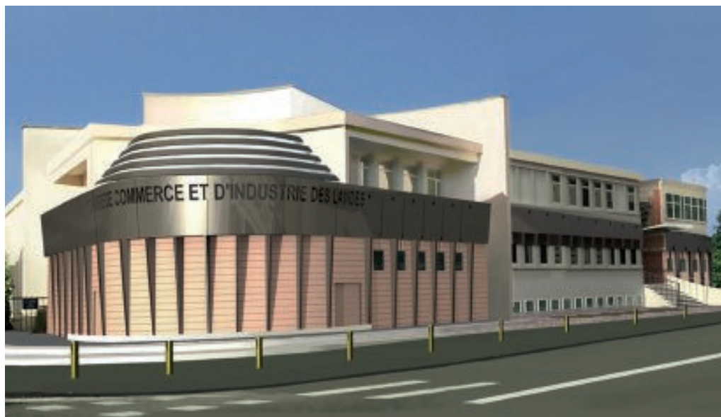
Le futur Centre de Conférences et de Séminaires à Mont-de-Marsan
