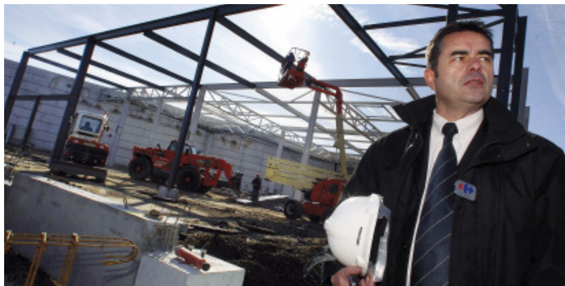
Autorisé par la Commission Départementale d'Équipement Commercial au début de l'été 2006, l'agrandissement du supermarché Carrefour à Dax, dirigé par Éric Bertaud, est aujourd'hui en cours de réalisation
