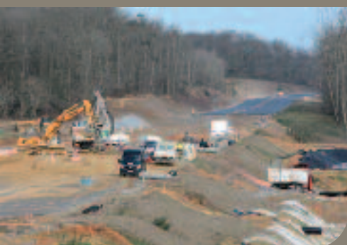
Le chantier de l'A65, ici à Aire-sur-l'Adour
